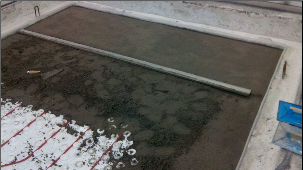
Coulage de la chape en mortier de ciment
