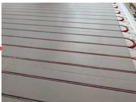
Application du primaire sur la partie aluminium
