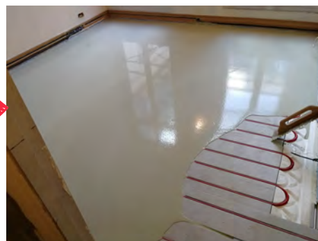
Application du ragréage (5mm mini/8mm maxi) au-dessus du tube
