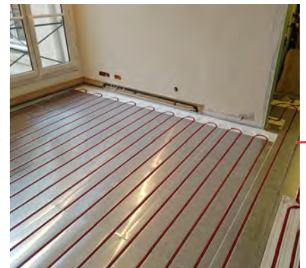
Pose des dalles et du tube selon plan de calepinage
