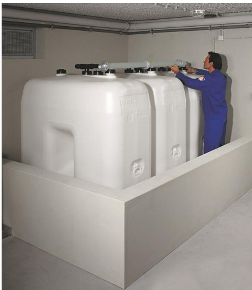
**ATTENTION : Une ventilation des réservoirs est obligatoire** pour permettre lors du soutirage du produit stocké un équilibre de pression par une entrée d'air et éviter une déformation de la cuve. (Idem lors du remplissage par raccord pompier, pour permettre l'évacuation de l'air).
